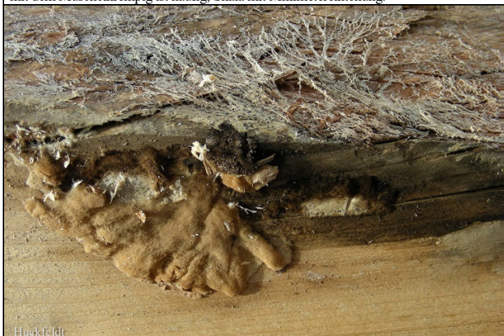
Abb. 8: Nebeneinander wachsender Doppelbefall des Muschelkremplings ( Paxillus panuoides , Braunfäule-Erreger – helle Stränge) und des Tannenblättlings ( Gloeophyllum abietinum , Braunfäule-Erreger – braunes Mycel, unten). Ein Doppelbefall mit dem Muschelkrempling ist häufig.
