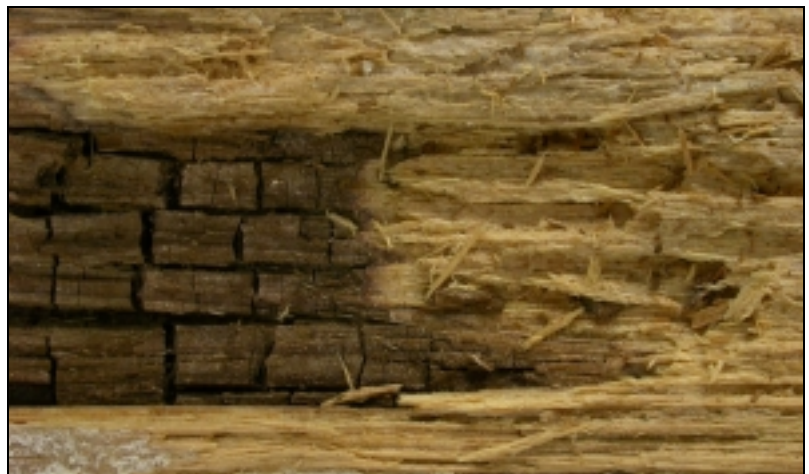
Abb. 5. Braun- und Weißfäule an einem Holzstück aus einem Dachboden. Braunfäule (Hausschwamm) links mit Würfelbruch und deutlich dunklerer Farbe als die Weißfäule (Hausporling) rechts.
