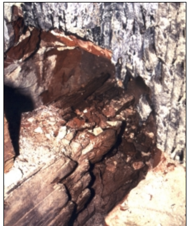
Abb. 6. Ein durch den Echten Hausschwamm zerstörter Balkenkopf eines Fußbodens im Mauerauflager (freigelegt); Balken 18 x 24 cm. Ein Größenvergleich der Hyphen im Holz ist in Abb. 11 gezeigt.
